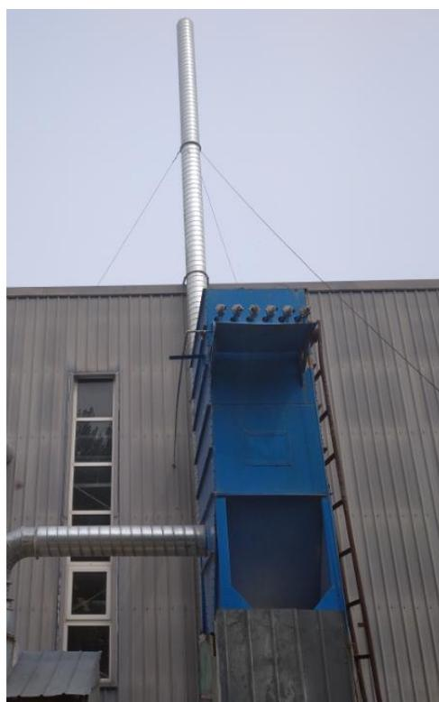
实木车间木工工序：脉冲布袋除尘器+15m 高排气筒
