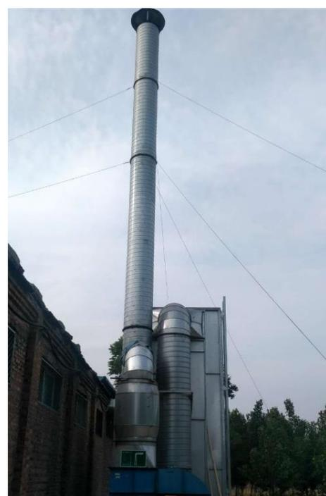
木门车间打磨剂砂光工序：布袋除尘器+15m 高排气筒
