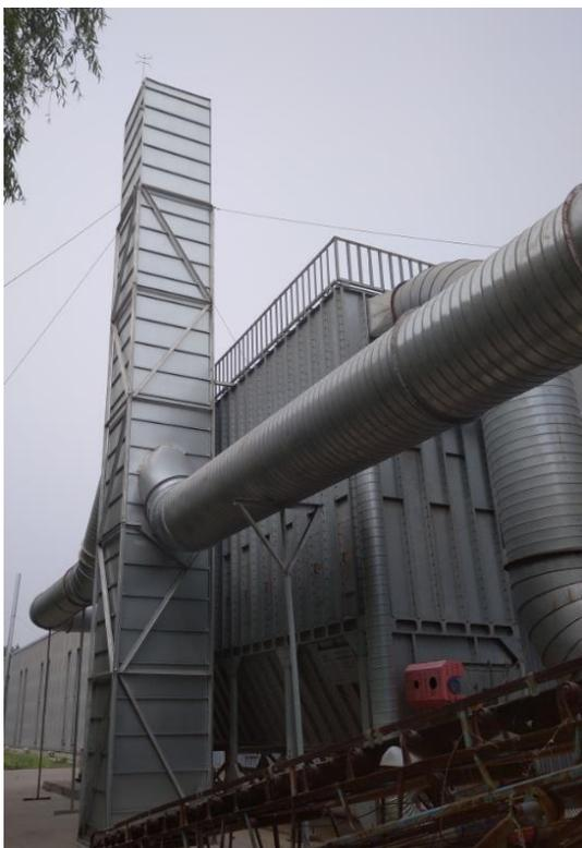
木门车间木工工序：脉冲布袋除尘器+2 根 18m 高排气筒
