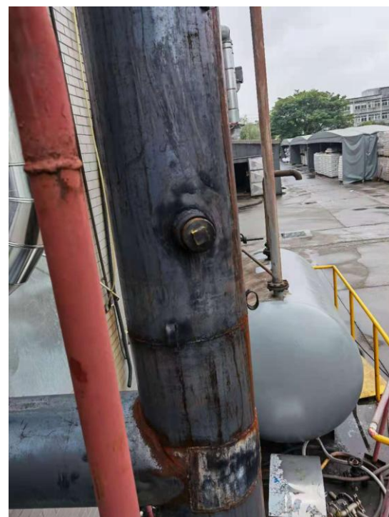
有组织废气: 2号锅炉废气排放口
