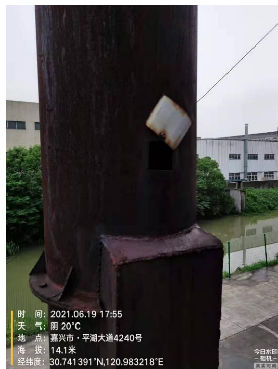
有组织废气: 1号锅炉废气排放口
