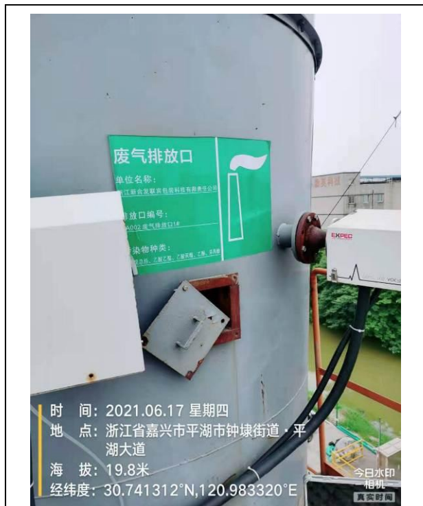
有组织废气: 印刷废气排放口
