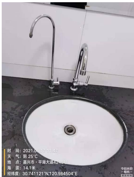
生活饮用水: B幢办公室二楼厕所饮水机旁 饮用水出水口
