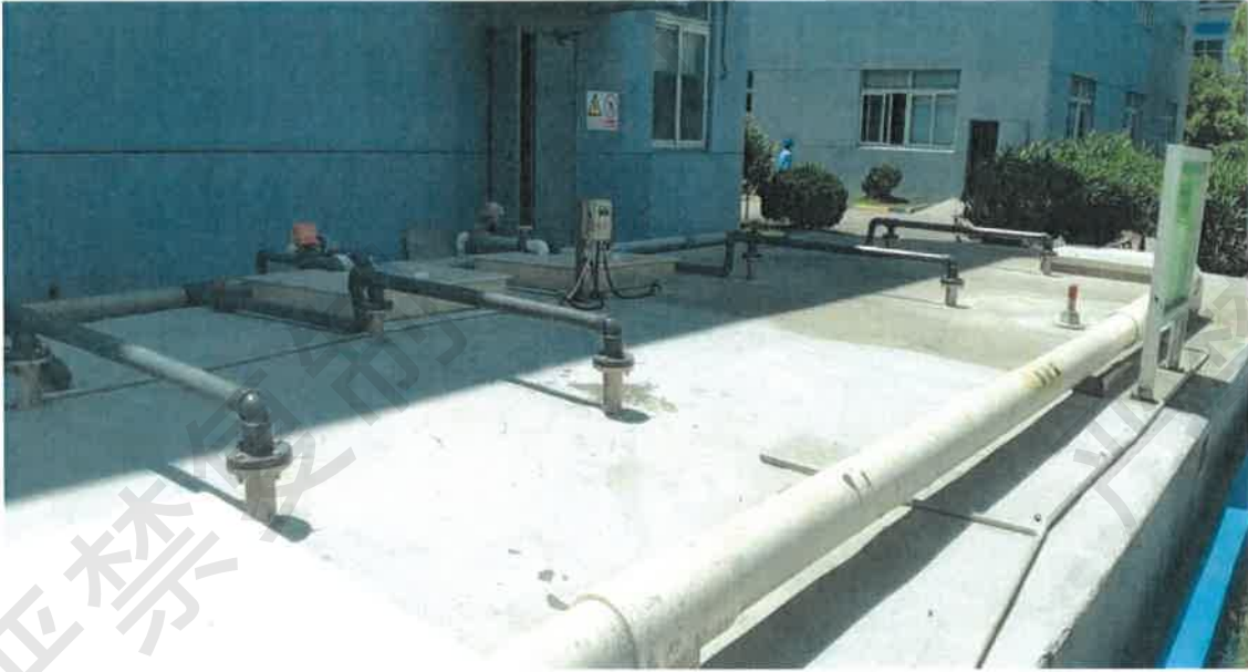
附图 3.1.3 酸性池上曝气管图
