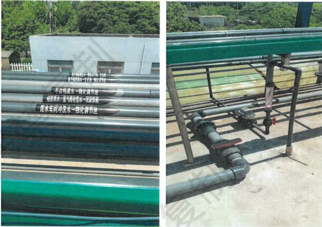
附图 2.1.1 高位池整改后具有管道流向标现场示意图
