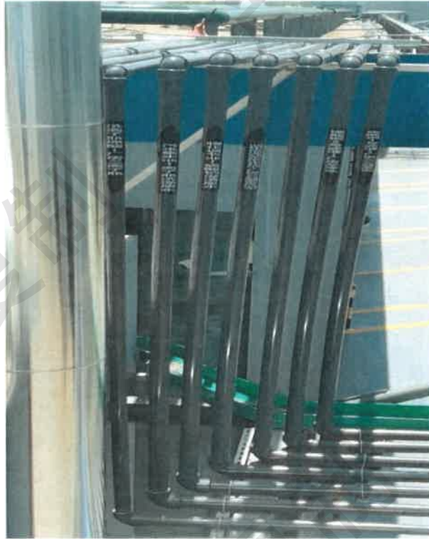
碱式碳酸铜生产线滤液管道现场图
