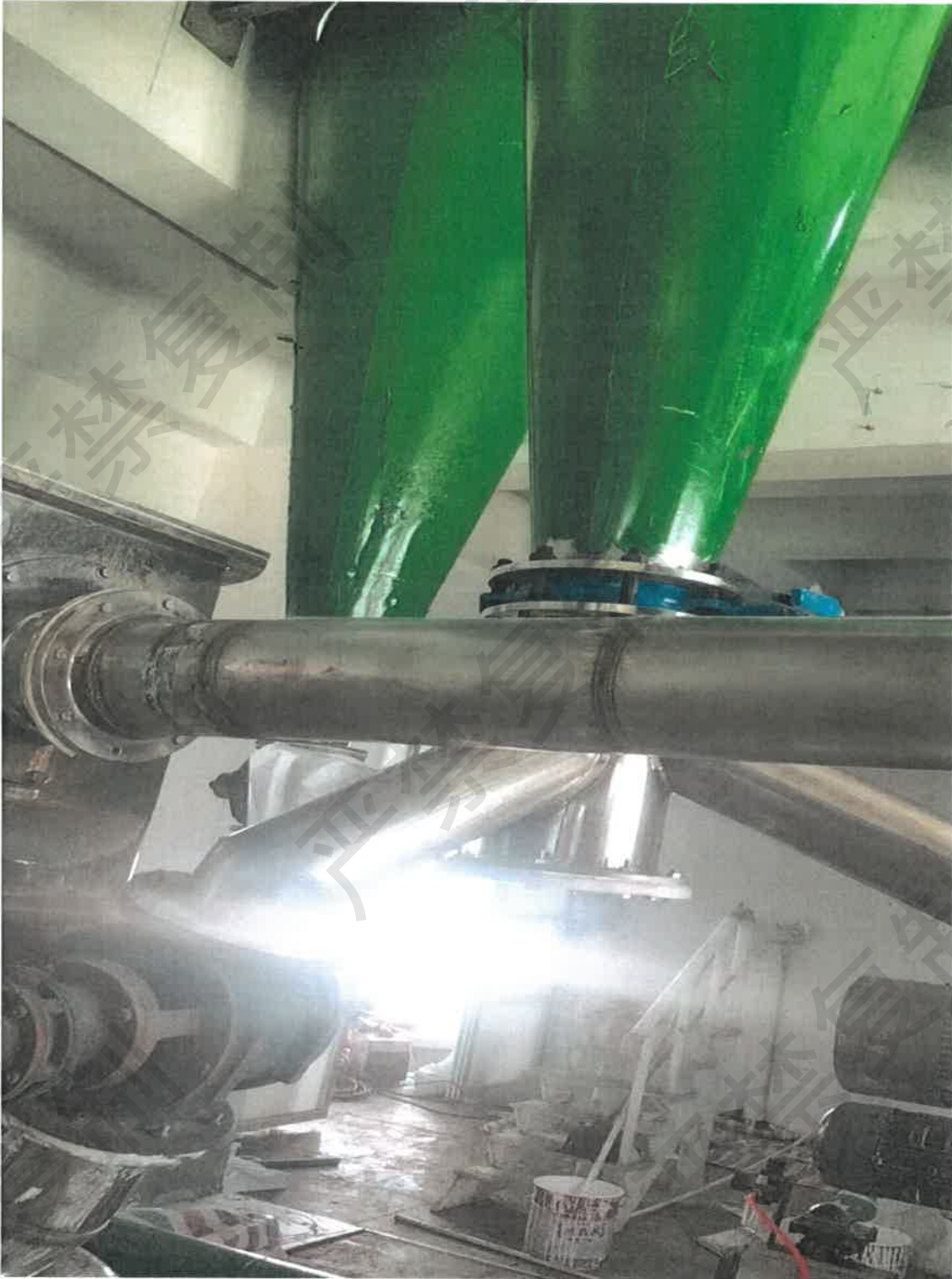
附图 2.2.2 旋风收集器整改后收集器设备图
