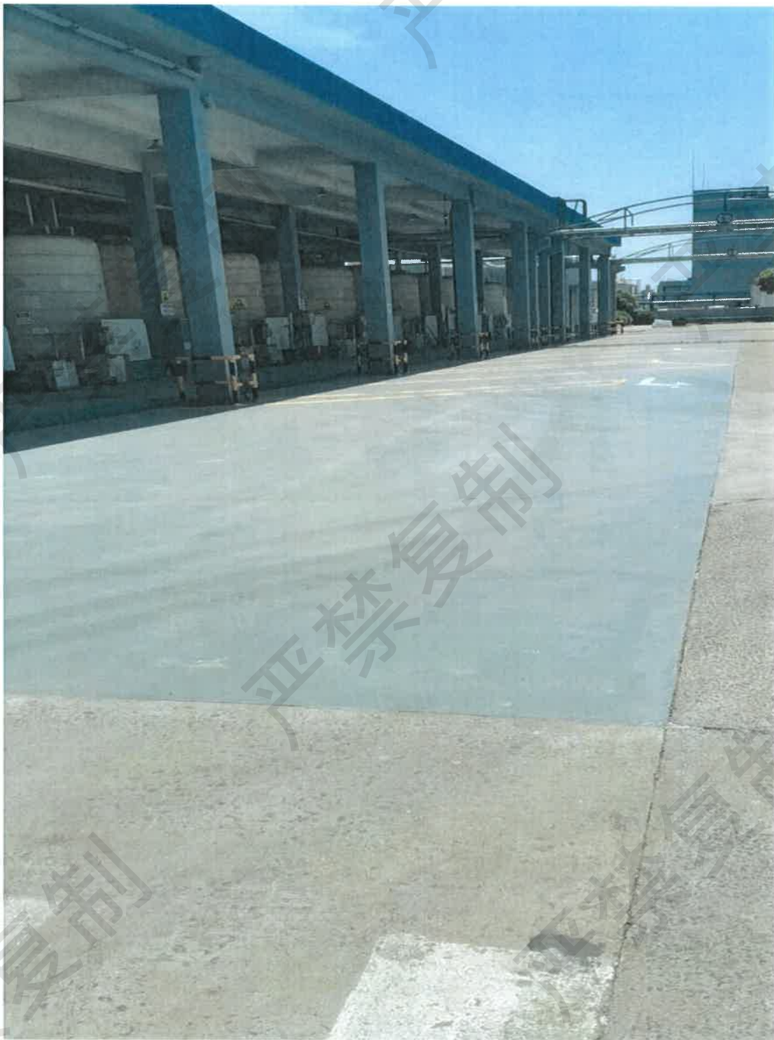
附图 3.1.4 装卸区整改后防腐图
