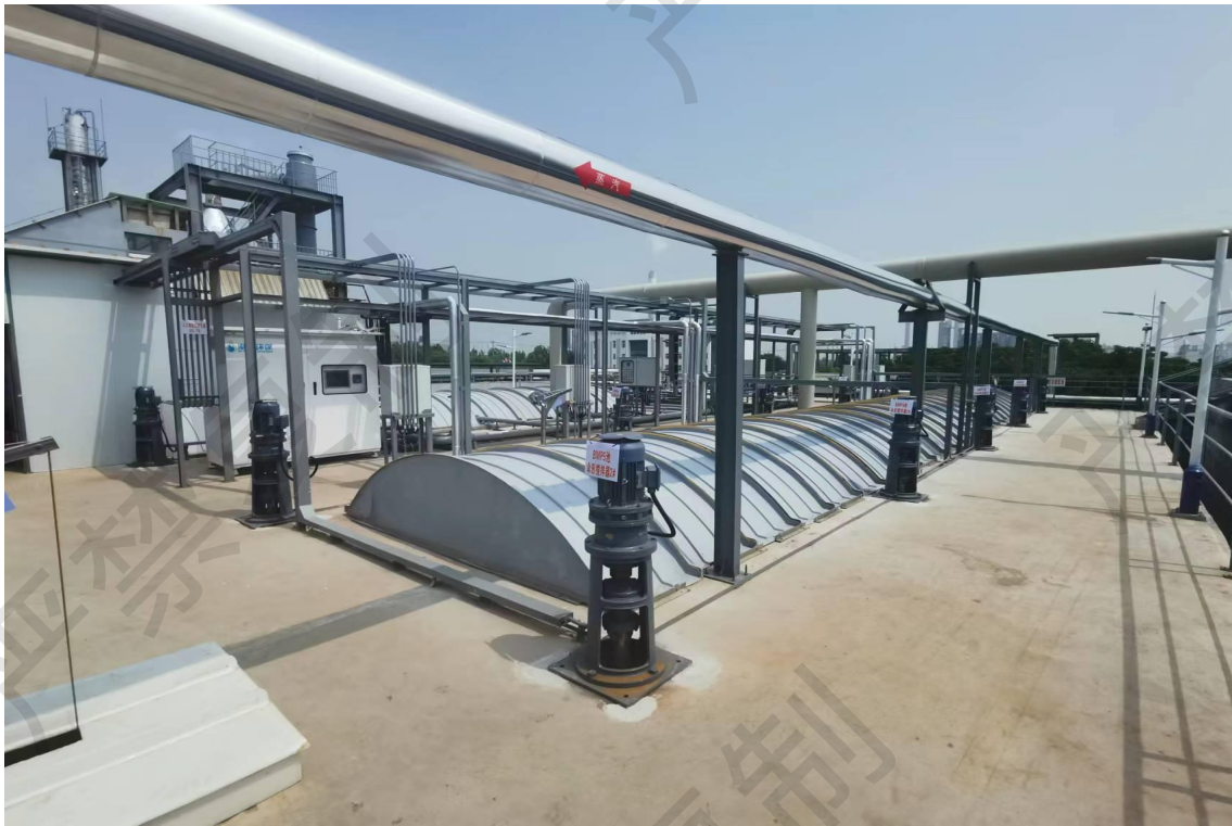
附图 2.3.1 废水生化处理系统设施现场图
