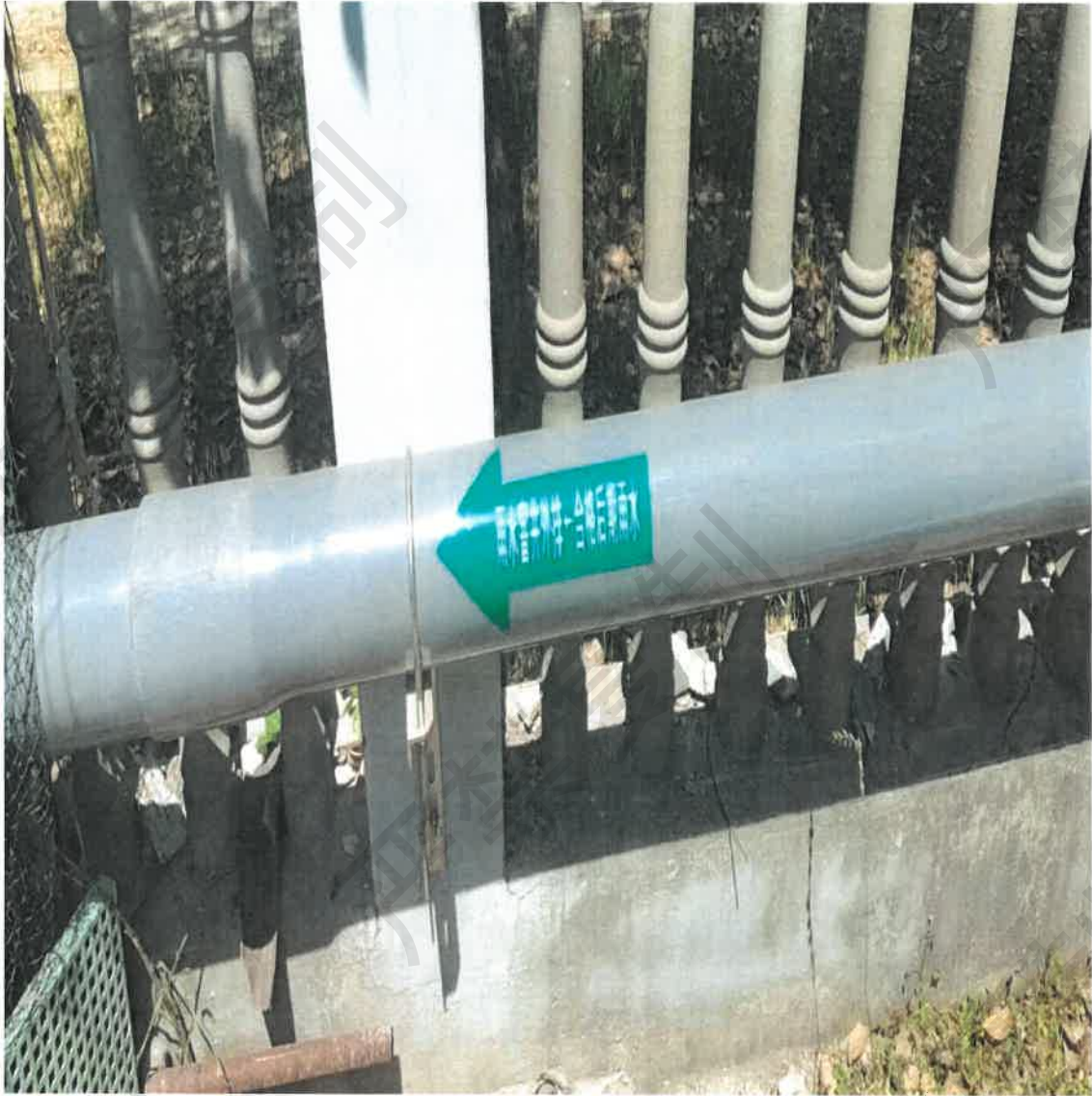
雨水收集池架空管道
