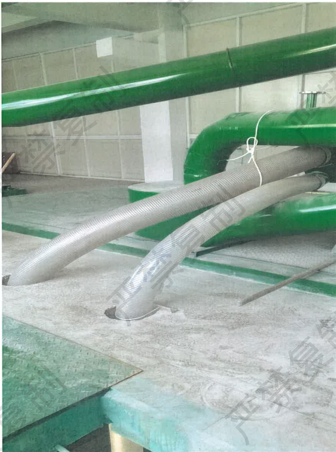
附图 2.2.1 2#车间烘干工段整改后新的气流管现场示意图
